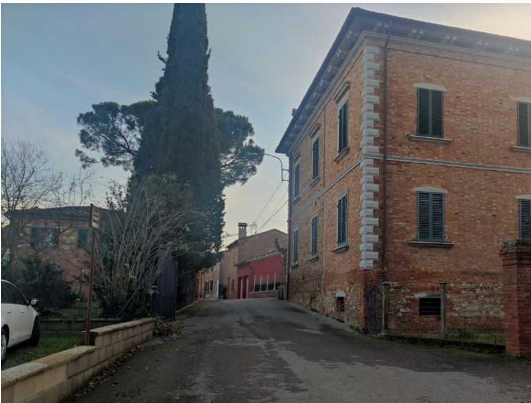
Figura 4 - Vista Nord – Est
