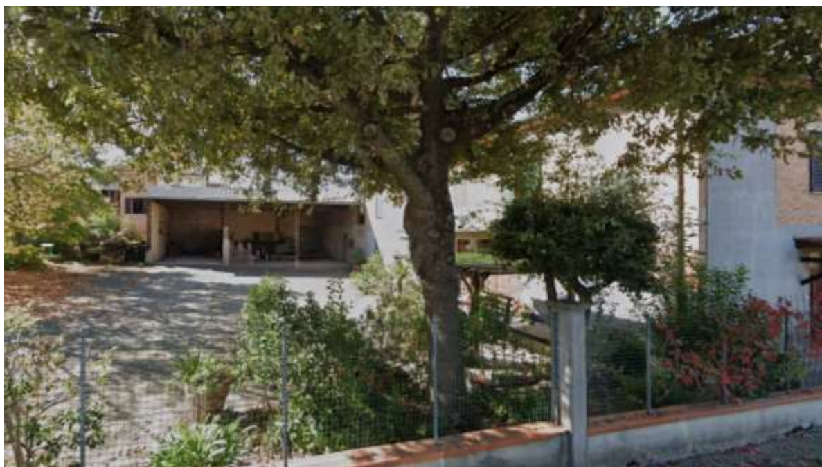
FOTO 5 – Veduta del capannone.-
