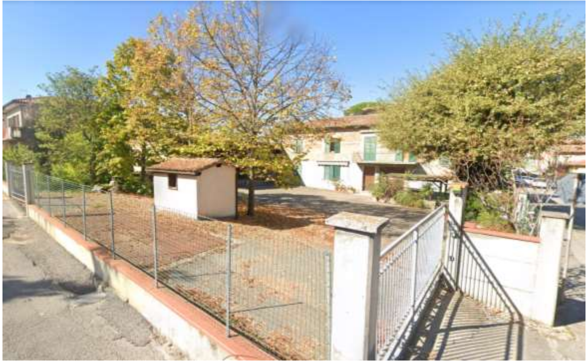
FOTO 1 – Veduta del fabbricato residenziale.-
