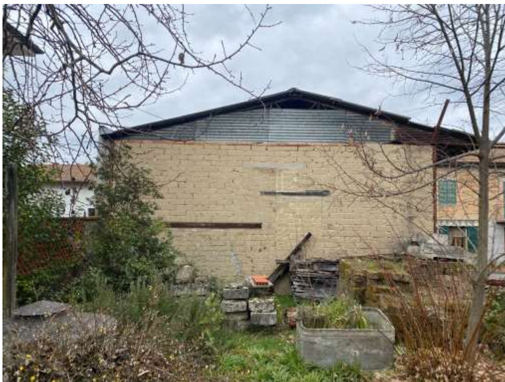
FOTO 3 – Veduta del capannone.-
