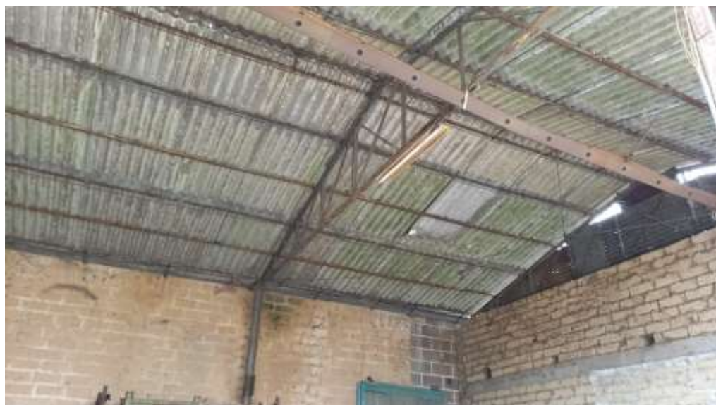
FOTO 9 – Veduta del capannone.-
