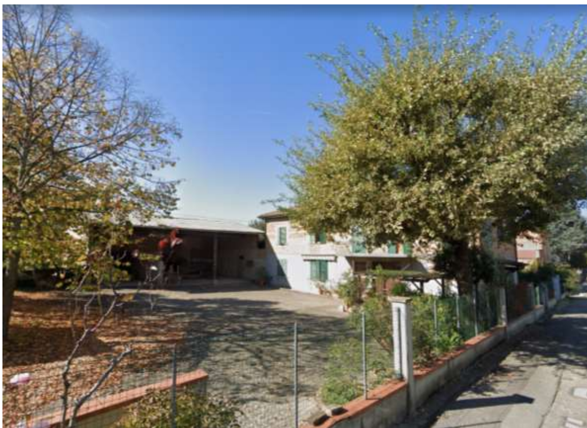
FOTO 4 – Veduta del capannone e della casa.-
