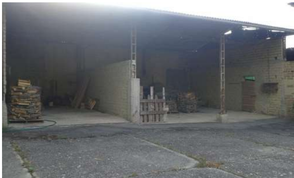
FOTO 11 – Veduta del capannone.-
