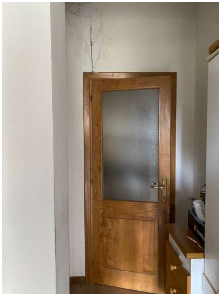
FOTO 13 – Veduta degli interni.-
