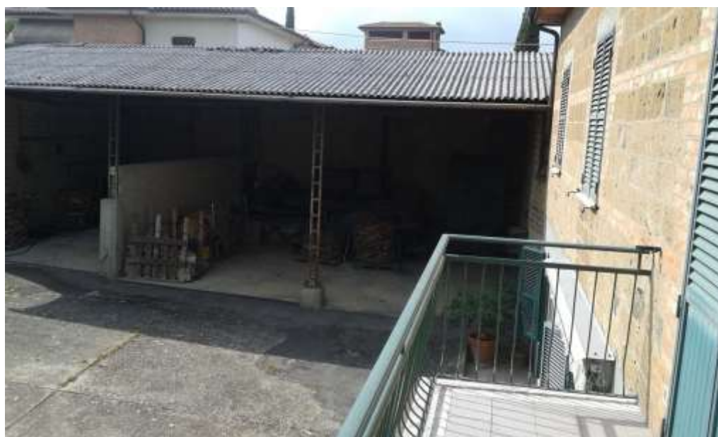
FOTO 10 – Veduta del capannone.-
