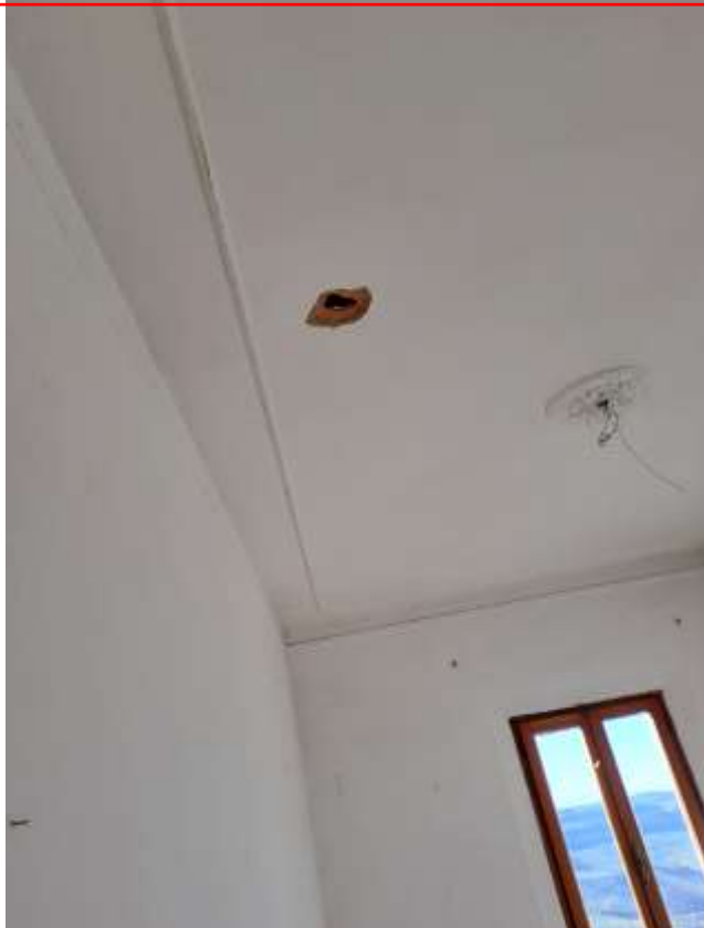
FOTO 10 – Dettaglio degli interni.-
