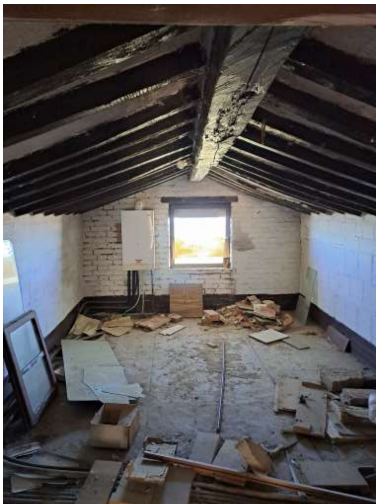
FOTO 8 – Dettaglio degli interni.-
