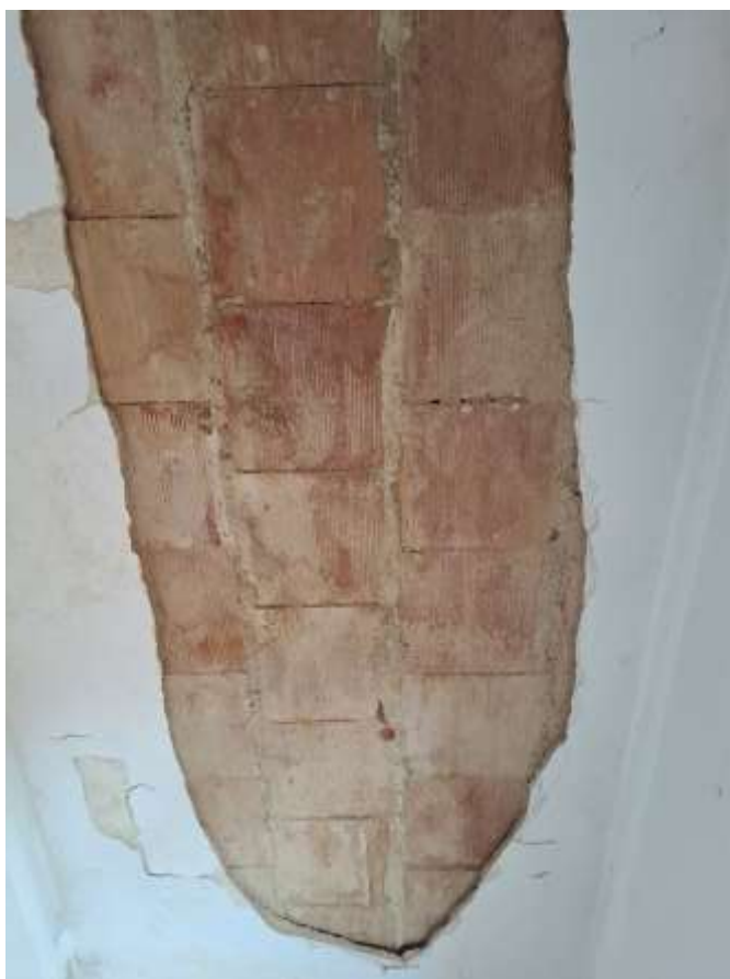
FOTO 11 – Dettaglio degli interni.-
