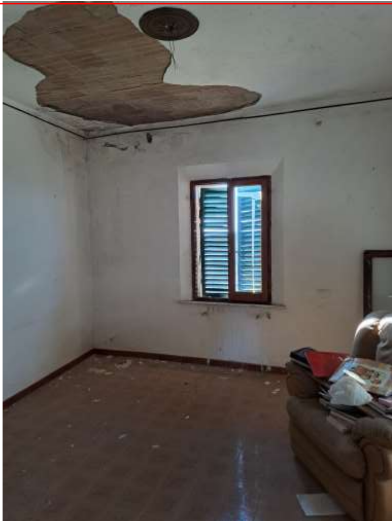
FOTO 6 – Dettaglio degli interni.-
