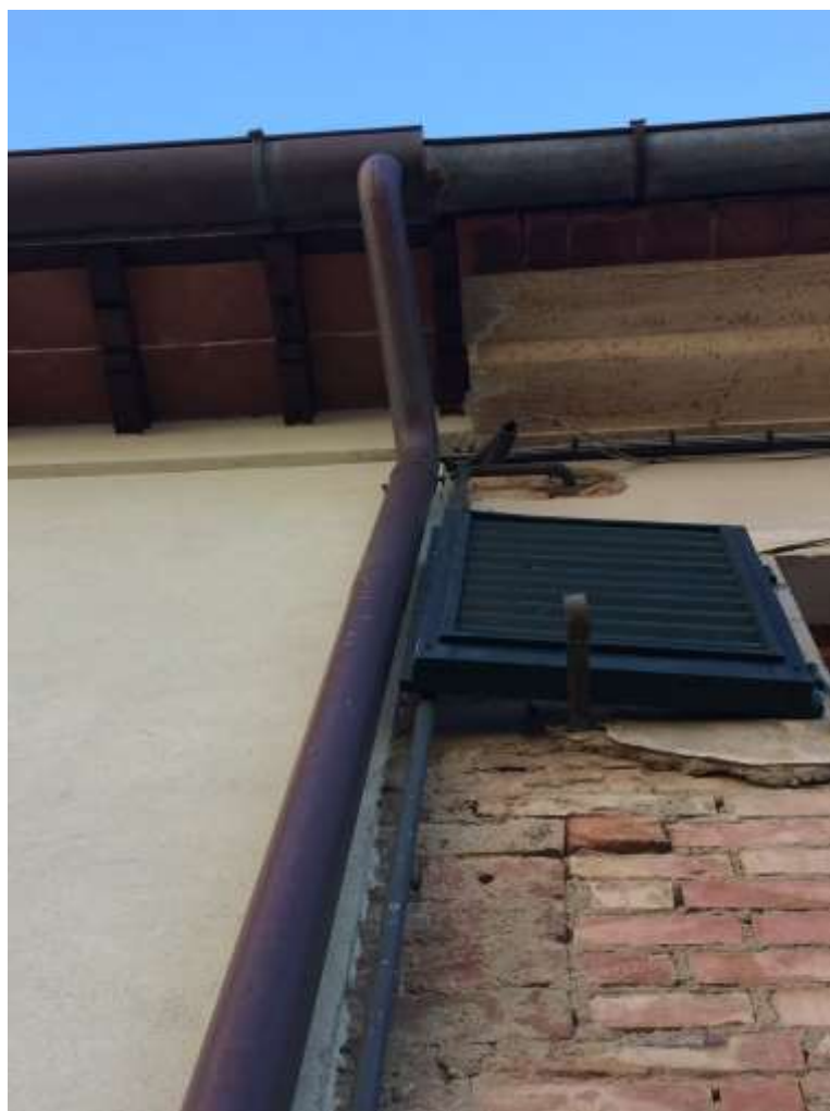
FOTO 4 – Dettaglio dello sporto di gronda.-
