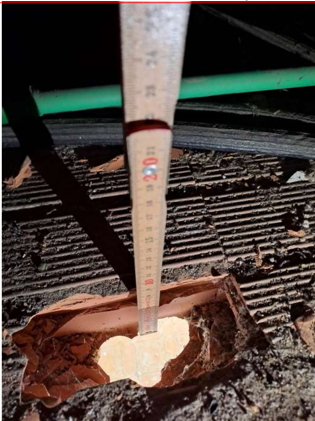
FOTO 9 – Dettaglio dello spessore del solaio interno.-
