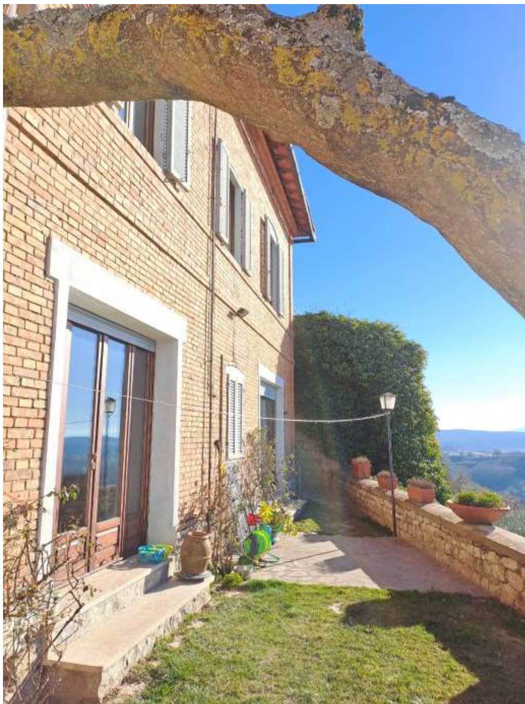
FOTO 3 – Veduta del fabbricato sul retro.-
