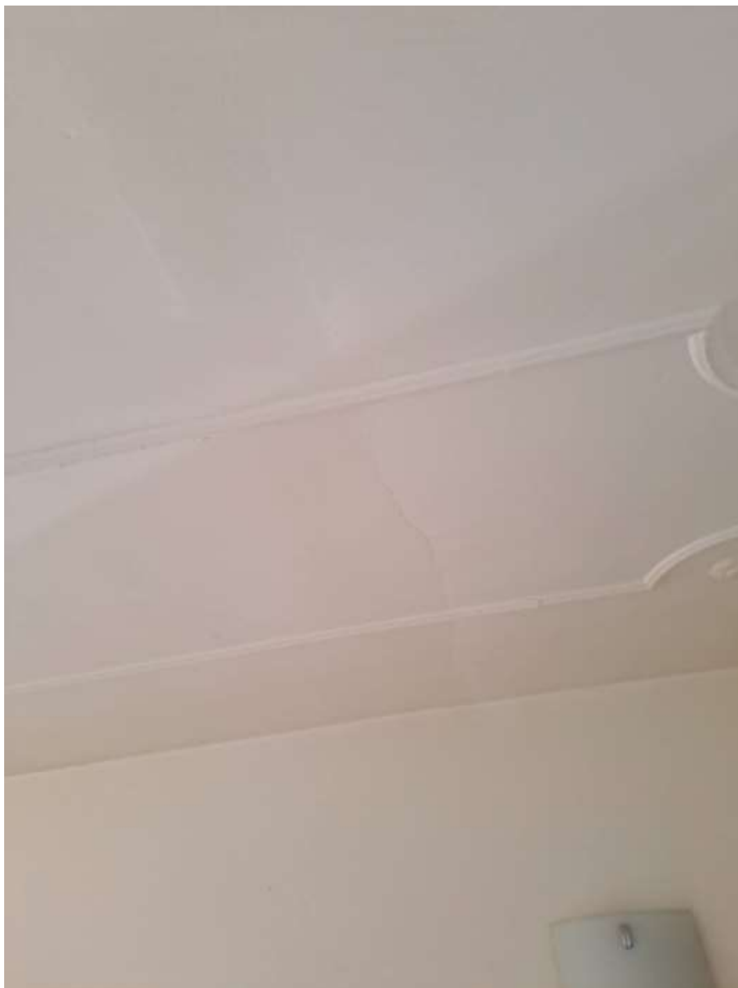
FOTO 10 – Veduta di alcuni soffitti interni.-
