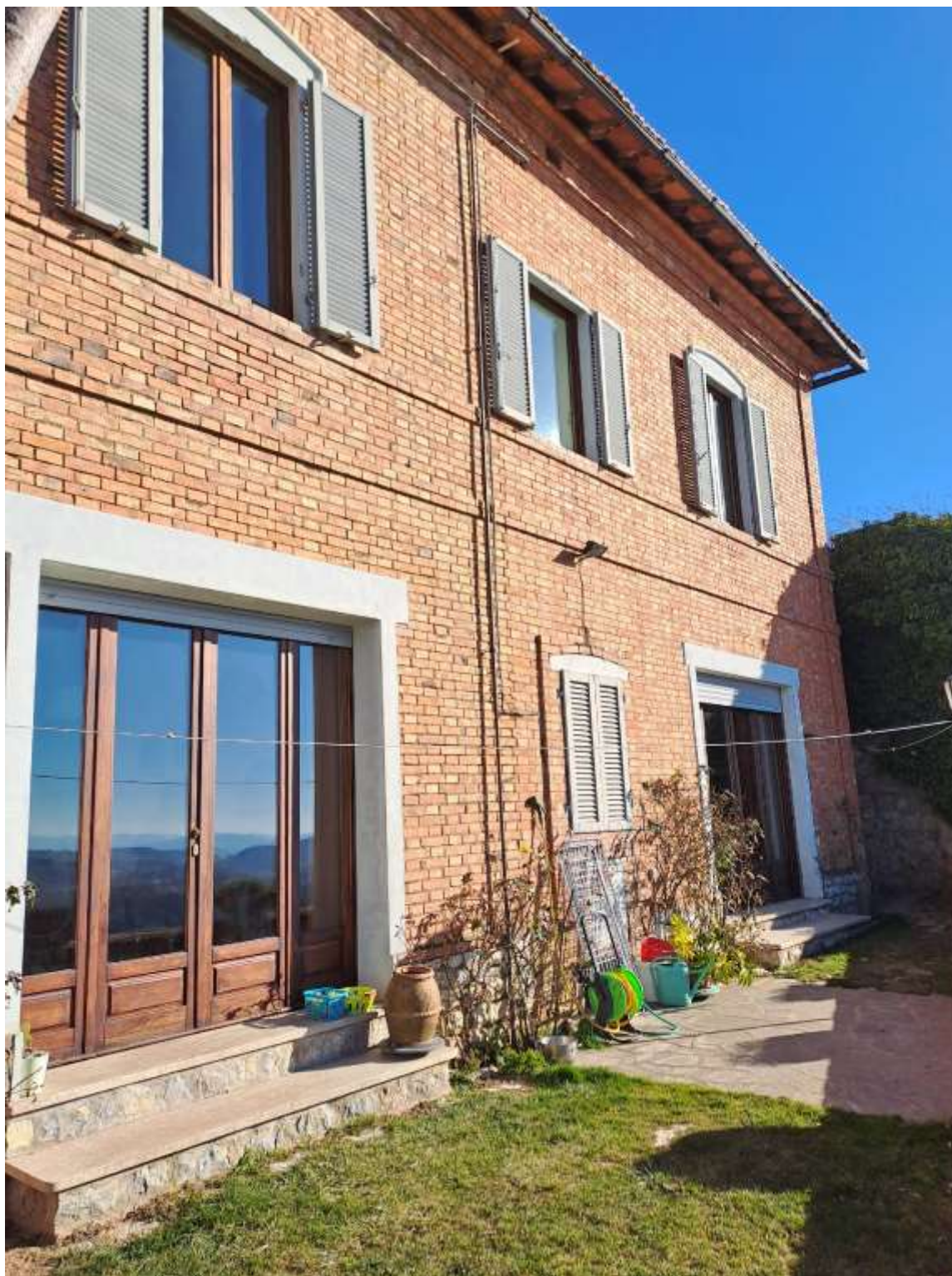
FOTO 4 – Veduta del fabbricato sul retro.-
