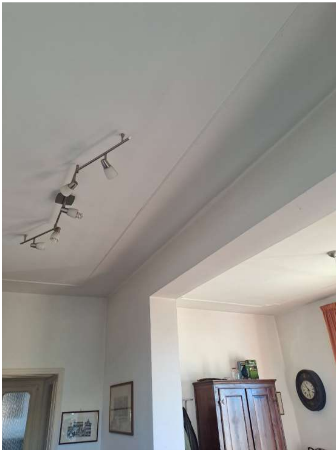
FOTO 6 – Veduta degli interni.-
