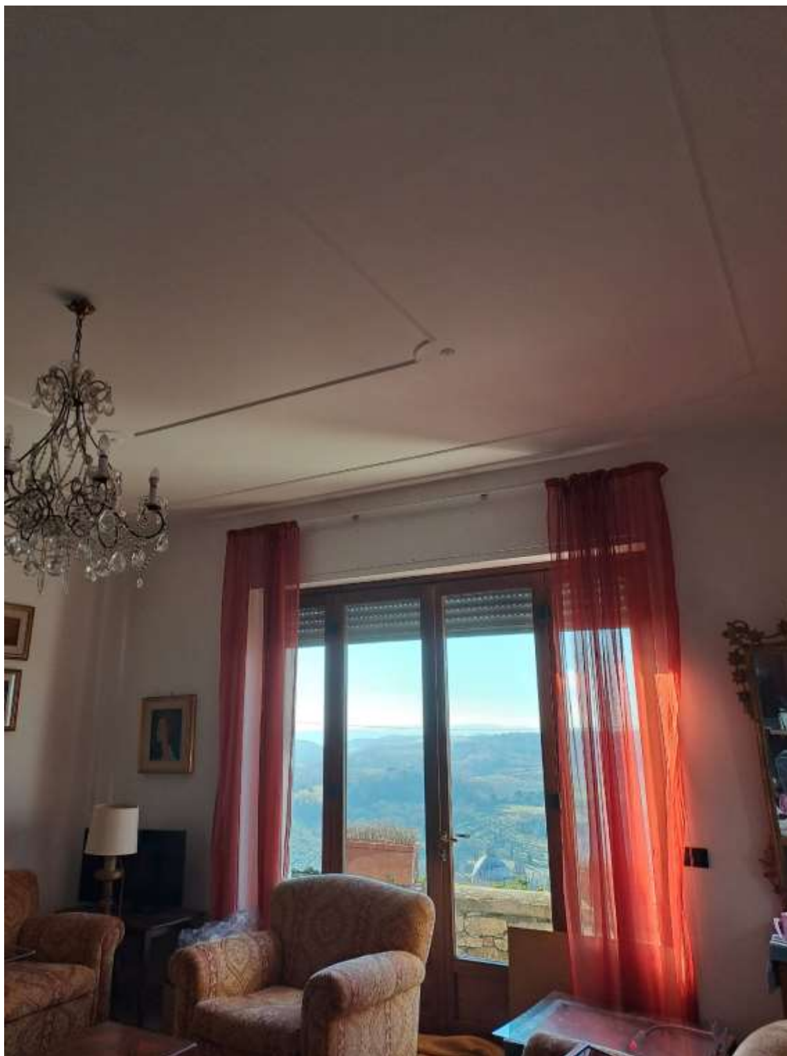
FOTO 8 – Veduta degli interni.-
