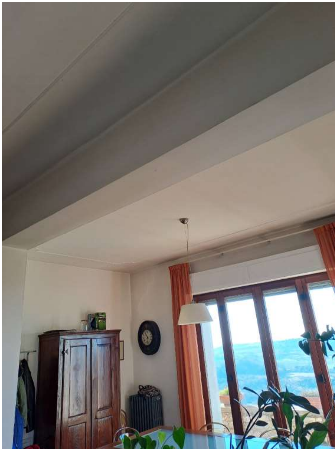
FOTO 7 – Veduta degli interni.-
