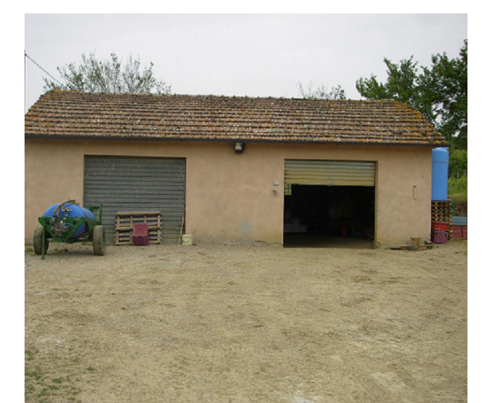
IMMOBILE "A" FOTO n.8
