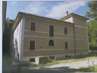
FOTO I: Prospetta Nord - Ovest
