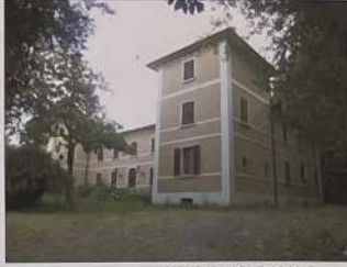
FOTO F: Vista della villa dal viale di accesso
