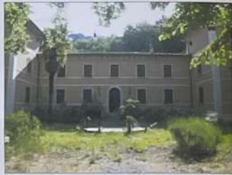
FOTO O: Prospetta Sud - Ovest
