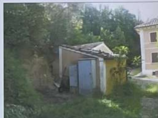
FOTO L: Vista della cabina elettrica
