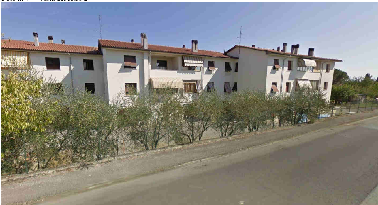
Foto n. 4 – Vista del retro 2
