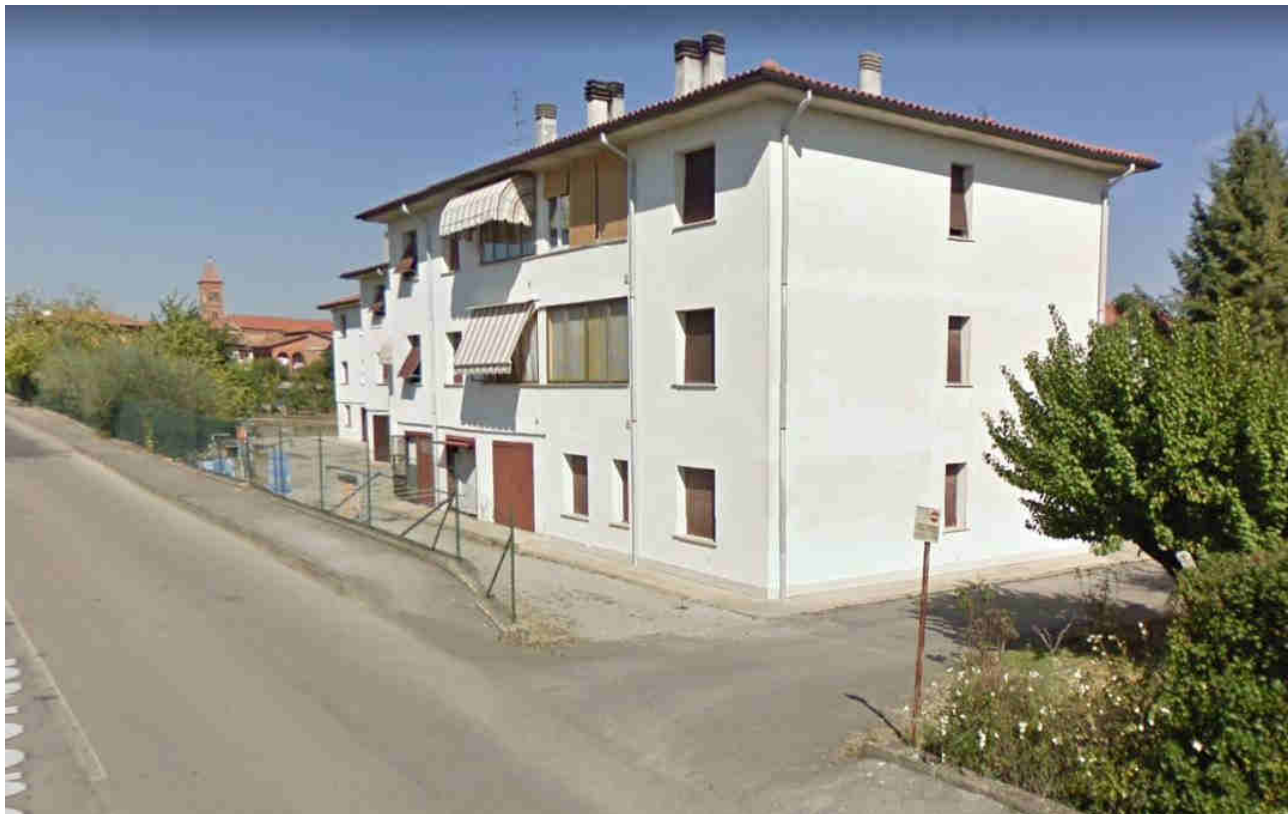
Foto n. 3 – Vista del retro 1
