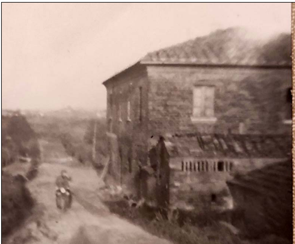
FOTO ORIGINARIA DEL 1950 CIRCA – TETTO A PADIGLIONE
