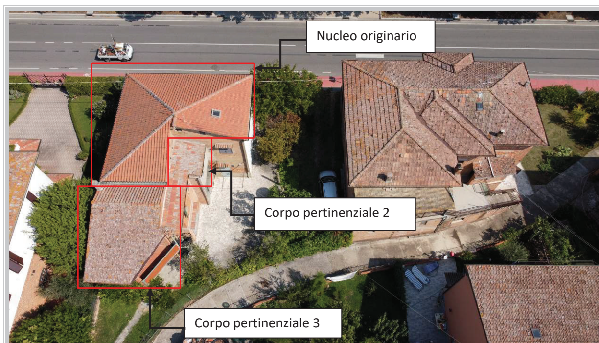
Foto 4 – Fabbricato in oggetto
