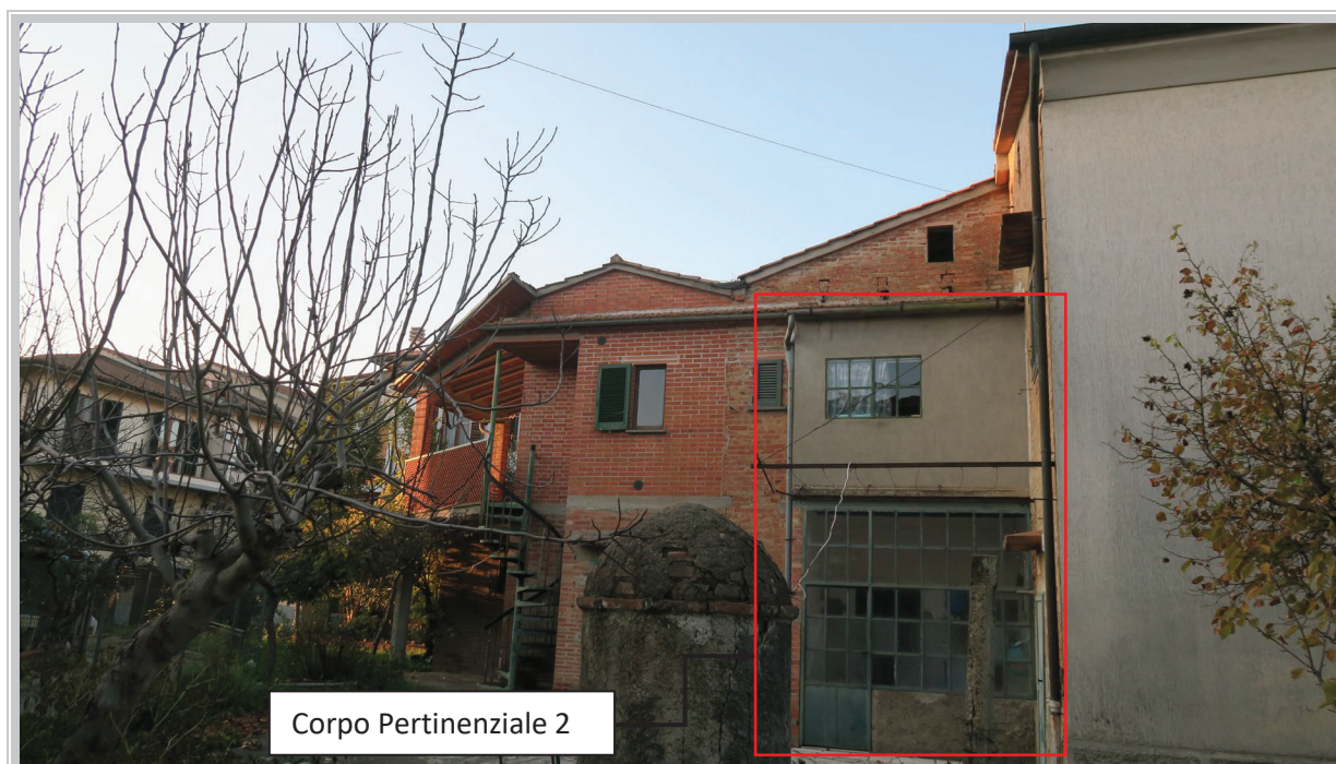
Foto 2 – Fabbricato in oggetto
