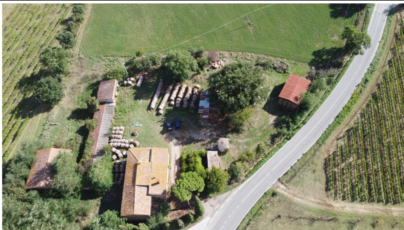
FOTO AEREA – IL COMPLESSO
