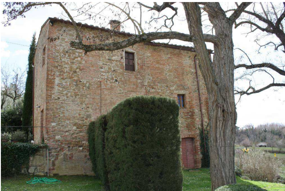
Fotografia 2 – Vista Nord ovest – Fabbricato Principale
