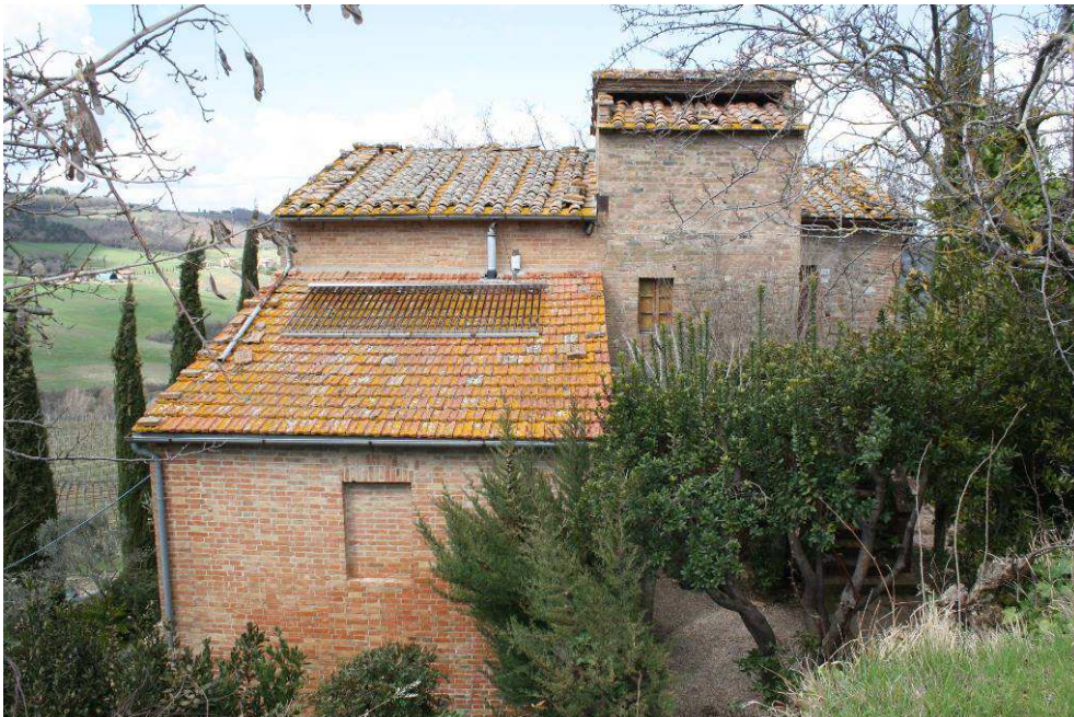
Fotografia 4 – Vista Sud est – Fabbricato Principale
