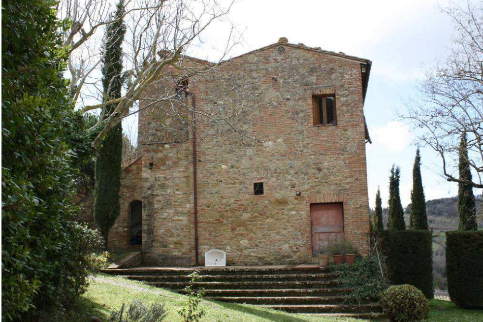
Fotografia 3 – Vista Nord est – Fabbricato Principale
