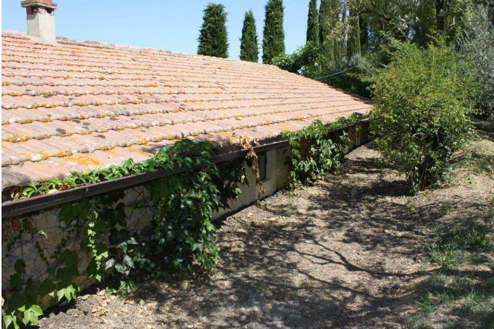
Fotografia 9 – Vista Sud est- Annesso 2
