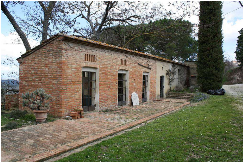
Fotografia 6 – Vista Sud ovest - Annesso 1
