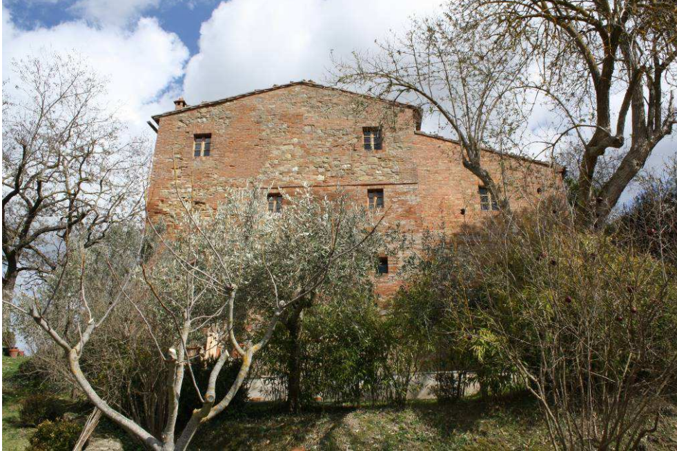
Fotografia 1 – Vista Sud ovest – Fabbricato Principale
