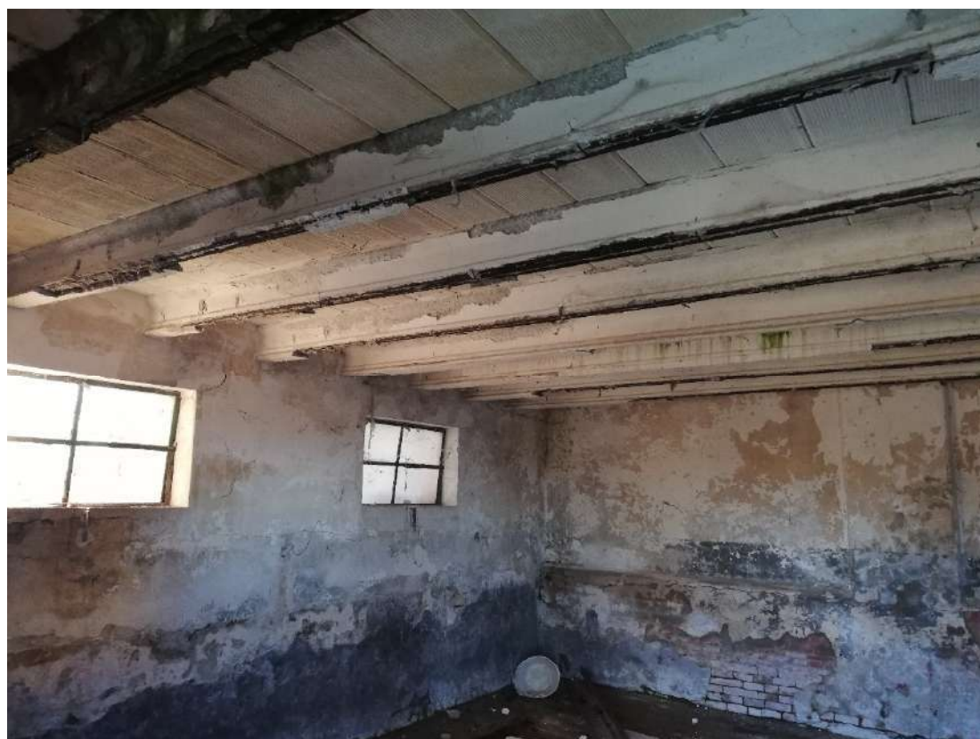
Foto situazione interna (piano terra)
