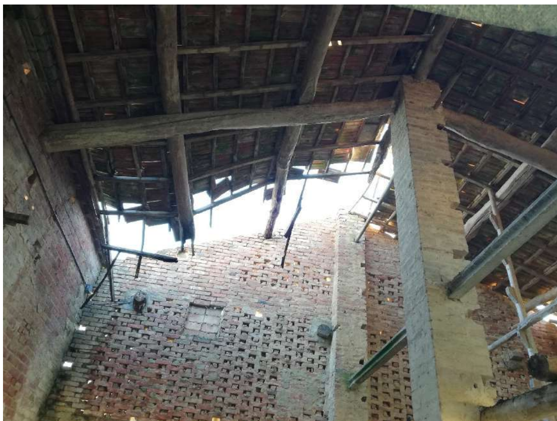
Foto situazione interna
