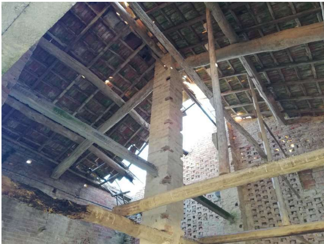
Foto situazione interna
