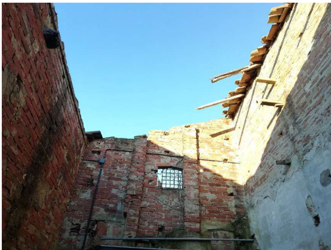
Foto situazione interna
