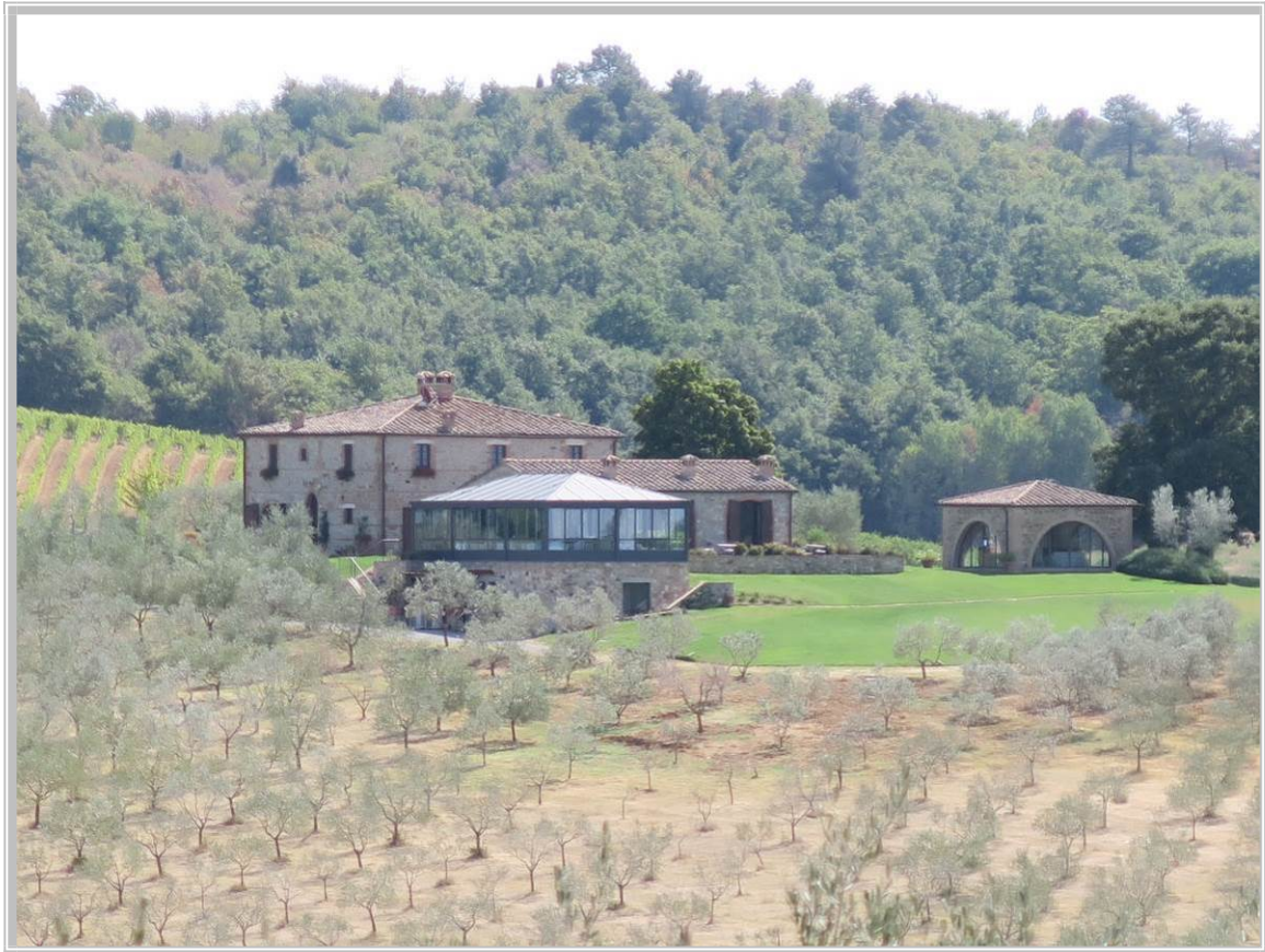
Foto 1 – Complesso Edilizio in oggetto
